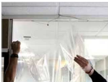
13. Retirer le liner de protection extérieur du film appliqué
